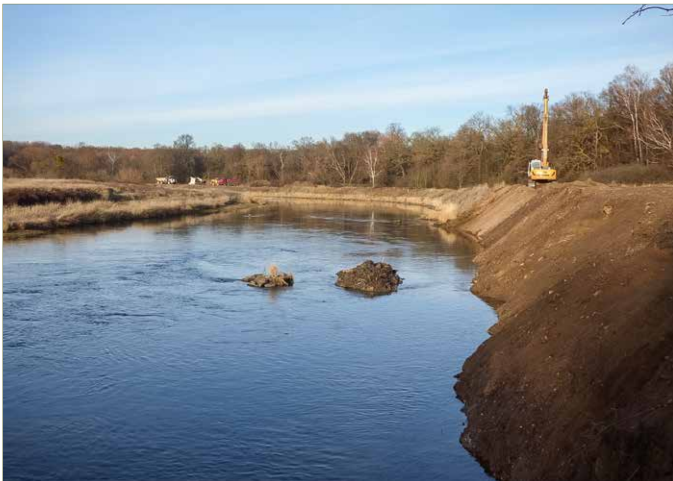
Abb. 3: Rückbau von sehr massiven Uferbefestigungen an Elbe, Mulde und Havel schafft Biotope und lässt natürliche dynamische Prozesse wieder zu, hier Uferrückbau im Rahmen des Bundesprogrammes Biologischen Vielfalt-Projektes Wilde Mulde (Träger WWF). Foto: G. Puhlmann
