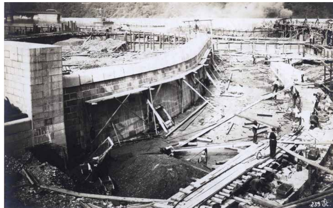
Výstavba Helmovského jezu
