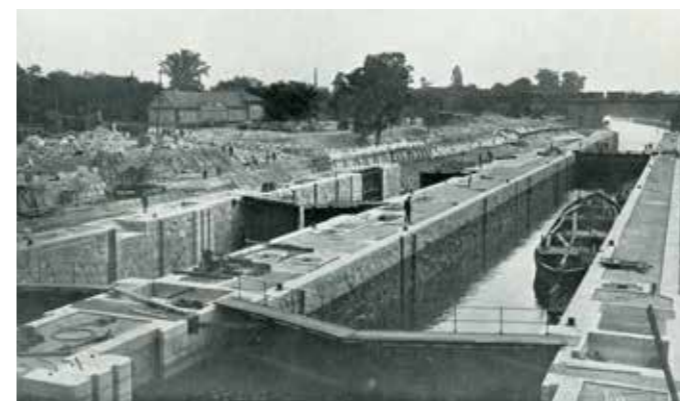
Výstavba plavební komory
