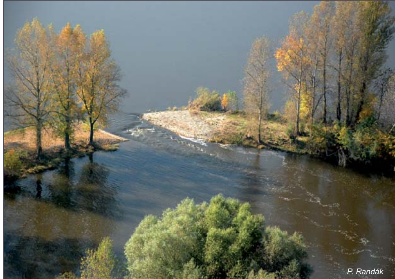
Einkerbung des Leitwerks bei Černěves Průleh v koncentrační hrázi, Černěves
