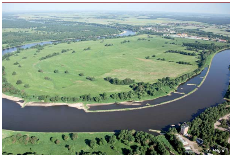
Luftbild der Maßnahme Dessau-Wallwitzhafen, Mai 2011 Letecký snímek opatření Dessau-Wallwitzhafen, květen 2011
