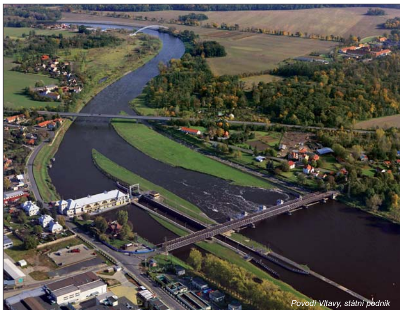
Luftaufnahme vor Beginn der Arbeiten Letecké foto před zahájením prací
