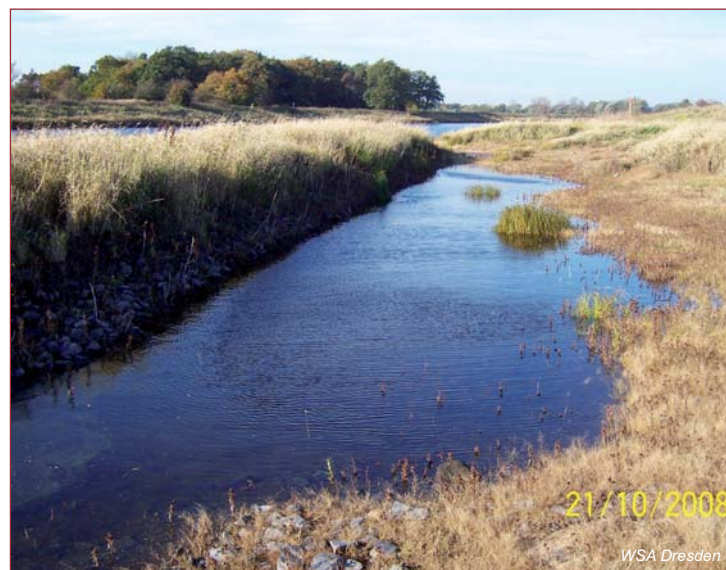
Parallelwerksende Gallin, Oktober 2008 Zakončení koncentrační hráže Gallin, říjen 2008
