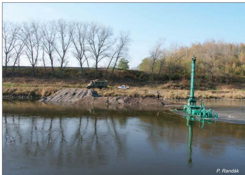
Gewässerunterhaltung mit einem Unterwasserbulldozer Údržba koryta podvodním dozerem
