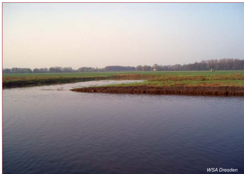
Beräumtes Bühnenfeld Elbe-km 209, April 2011 Vycištěné výhonové pole, Labe ř. km 209, duben 2011
