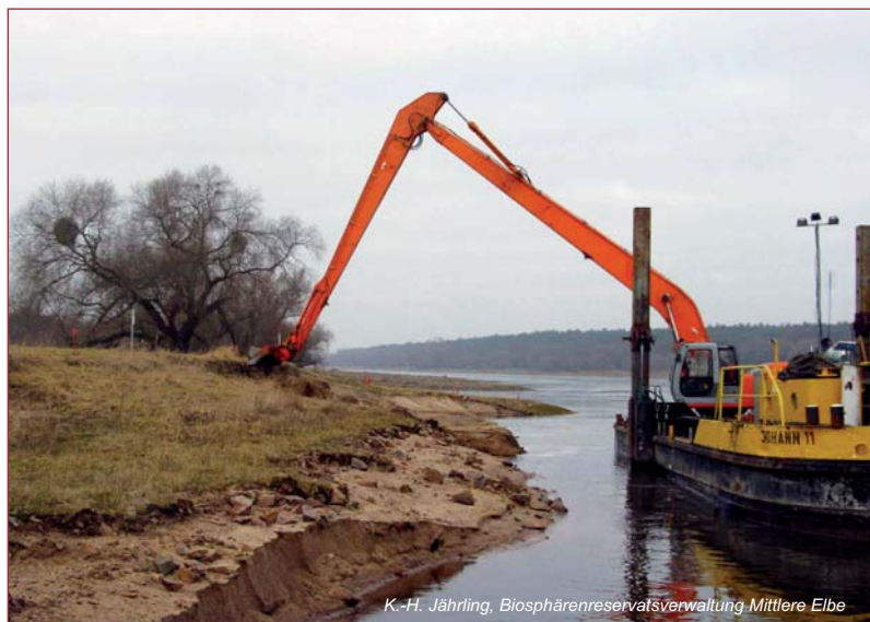
Rückbau Deckwerk Steckby, Dezember 2004 Odstranění břehového opevnění u Steckby, prosinec 2004
