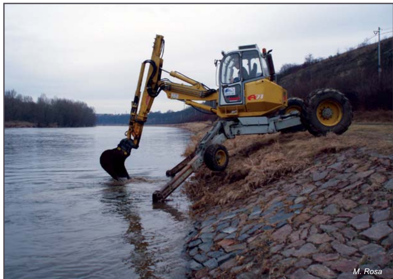
Instandsetzung des Deckwerks unter Verwendung des ursprünglichen Materials Oprava opevnění břehů s využitím původního materiálu
