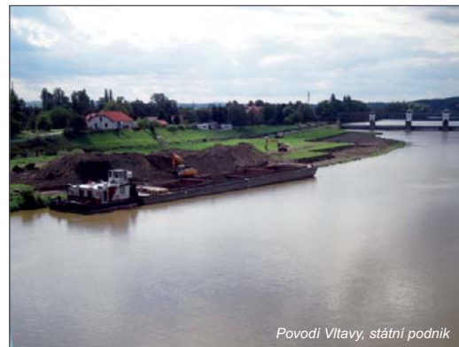
Ausbauarbeiten an der Insel (Blick von der Straßenbrücke gegen den Strom) Práce na úpravě ostrova (pohled ze silničního mostu proti vodě)
