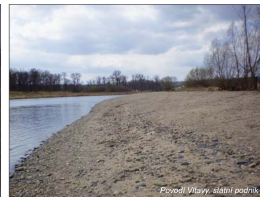
Blick gegen den Strom auf den fertigen Ausbau des linken Ufers Pohled proti vodě na dokončenou úpravu levého břehu
