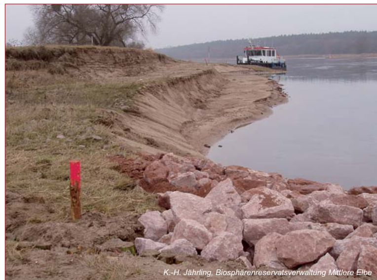
Rückbau Deckwerk Steckby, Dezember 2004 Odstranění břehového opevnění u Steckby, prosinec 2004
