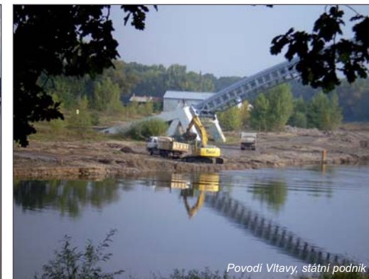
Ausbau des linken Ufers Provedení úpravy levého břehu
