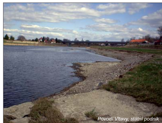
Blick in Stromrichtung auf den fertigen Ausbau der Insel Pohled po vodě na dokončenou úpravu ostrova
