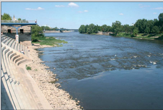
Elbe beim Domfelsen Magdeburg, August 2013 (Foto: Jährling, LHW). Skalnatý úsek Labe, tzv. Domfelsen, v Magdeburku, srpen 2013 (Foto: Jährling, LHW).
