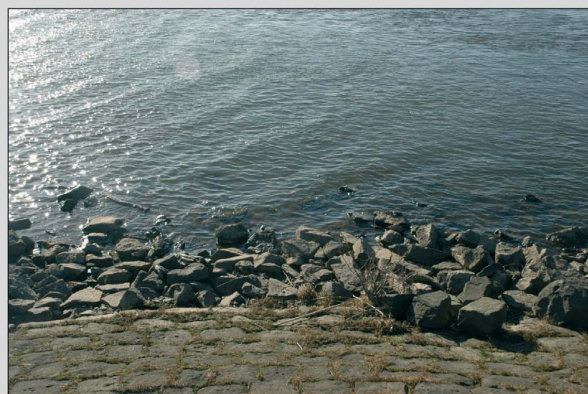
Uferverbau an der Elbe, 2014 (Foto: Quick, BfG). Opevnění břehu na Labi, 2014 (Foto: Quick, BfG).
