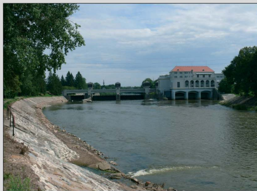
Wehrsystem in Prielouč nad Labem an der tschechischen Elbe - Regulation der natürlichen Dynamik des Sedimenttransports (Foto: Šmidová, 2012). Systém jezů na českém úseku Labe výrazně reguluje přirozenou dynamiku transportu sedimentů. Jez v Prielouči nad Labem (Foto: Šmidová, 2012).
