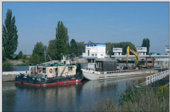
Baggerung und Wasserstraßenunterhaltung sind zusammen mit dem Wehrsystem die bedeutenden Faktoren, die die natürliche Variabilität der Sohlentiefe beeinflussen (Foto: Langhammer, 2012). Prohrabky koryta a udržování plavební dráhy představují spolu se systémem jezů významné faktory, ovlivňující přirozenou variabilitu hloubek koryta (Foto: Langhammer, 2012).
