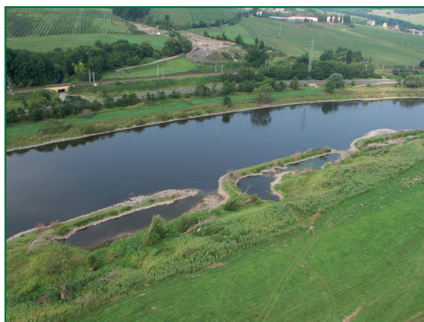
Abb. 6-7a: Leitwerke an der tschechischen unteren Elbe bei Nebočady (J. Medek, Povodí Labe, státní podnik)
