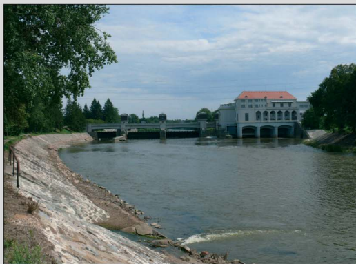
Wehrsystem in Přelouč nad Labem an der tschechischen Elbe - Regulation der natürlichen Dynamik des Sedimenttransports (Foto: Šmidová, 2012). Systém jezů na českém úseku Labe výrazně reguluje přirozenou dynamiku transportu sedimentů. Jez v Přelouči nad Labem (Foto: Šmidová, 2012).
