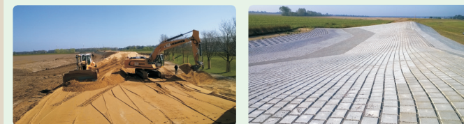
Deichneubau (links) und Überlaufschwelle (rechts) – Fotos: LAU Brandenburg
