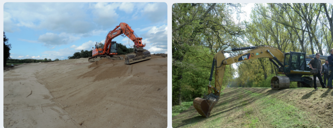
Deichneubau 2015 (links) und Schlitzung des Altdeichs 2017 (rechts) – Fotos: IKSE
