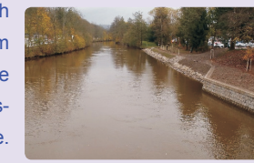
Sicherung des Gewässerbetts
