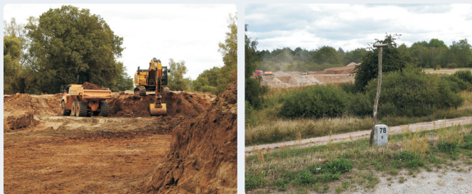
Deichrückverlegung Sandau Nord: Schlitzung des Altdeichs (links) und Bodenlager mit Material aus der Schlitzung des Altdeichs (rechts) – Fotos: MULE ST
