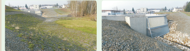
Dammbauwerk und Hochwasserrückhaltebecken (links) sowie Drosselbauwerk mit räumlichem Rechen (rechts) – Fotos: Stadt Selb
