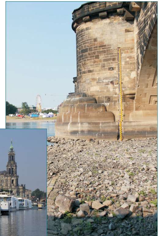
Elbe in Dresden, Pegellatte an der Augustusbrücke am 13.08.2015 (LfULG SN)
