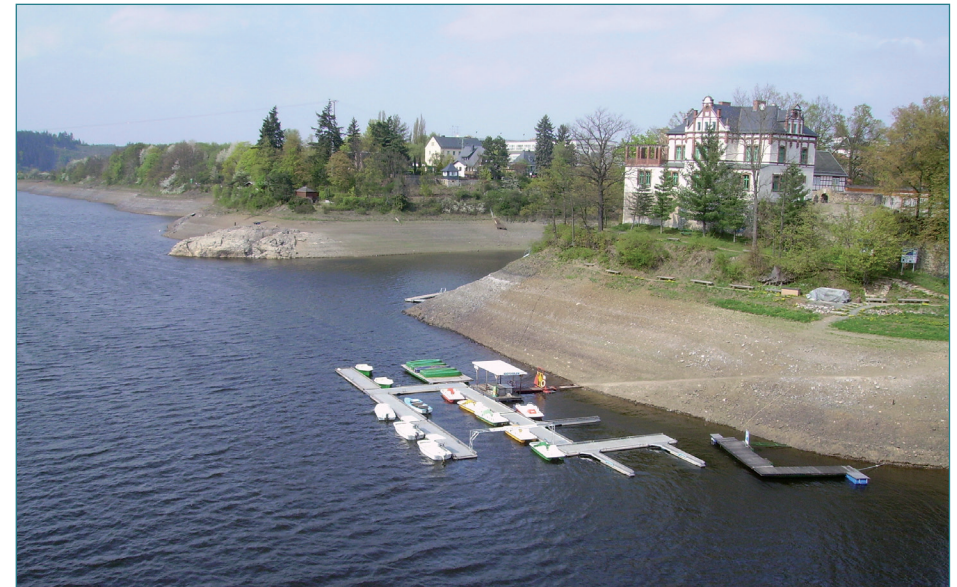
Aufgrund von Reparaturarbeiten abgesenkte Bleilochtalsperre im Jahr 2009 (TLUG)
